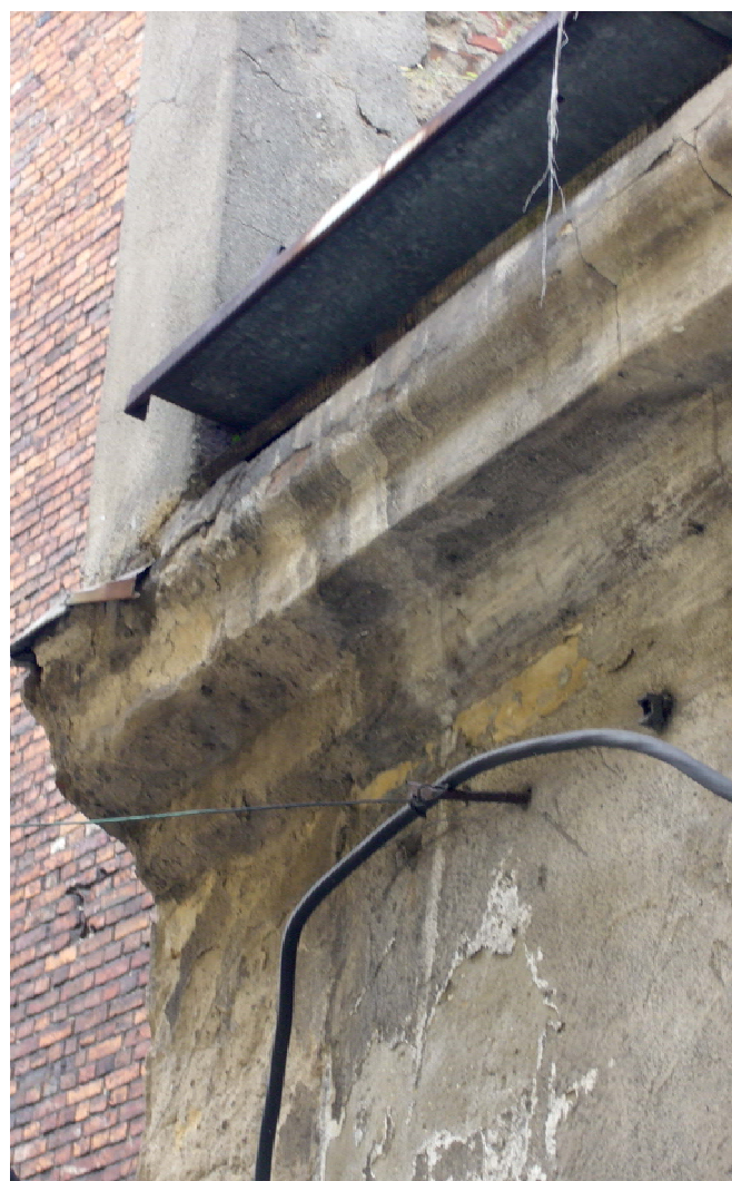
GZYMS BUDYNKU DO ZACHOWANIA I RENOWACJI FOTO 12
