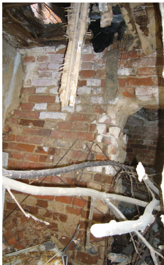
WNĘTRZE POMIESZCZENIA 01 Z WIDOKIEM NA ZAWALONE PRZEKRYCIE FOTO 16
